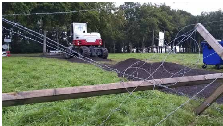
30 augustus 2017, Frank Hellinga legt de verharding aan van de toegangspoort foto Edwin Stolk
